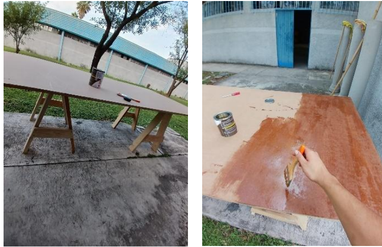
Figura 14. Construcción de la estructura soportante.
