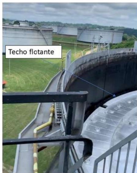
FIGURA 2.11: Mecanismo de techo flotante
