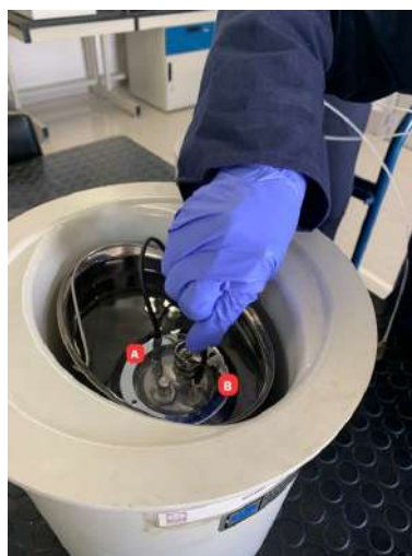
FIGURA A.43: Conexiones de energía a los fusibles.
