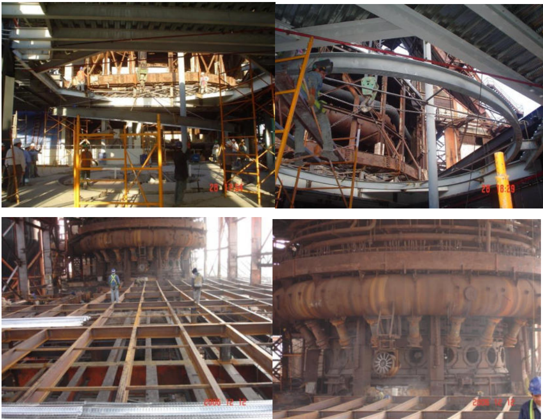
Fotos 17, 18, 19 y 20 Sustitución de estructura
