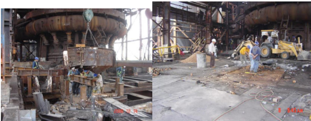
Fotos 5, 6, 7 y 8- limpieza de canales
