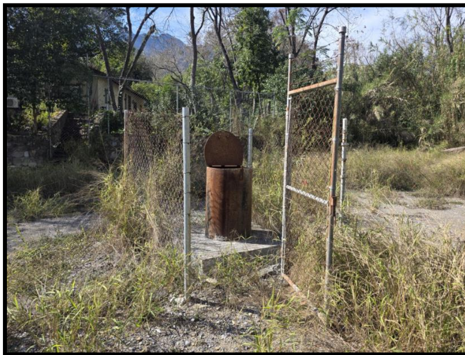
Figura 54. Pozo de extracción controlada desde el acuífero kárstico.
