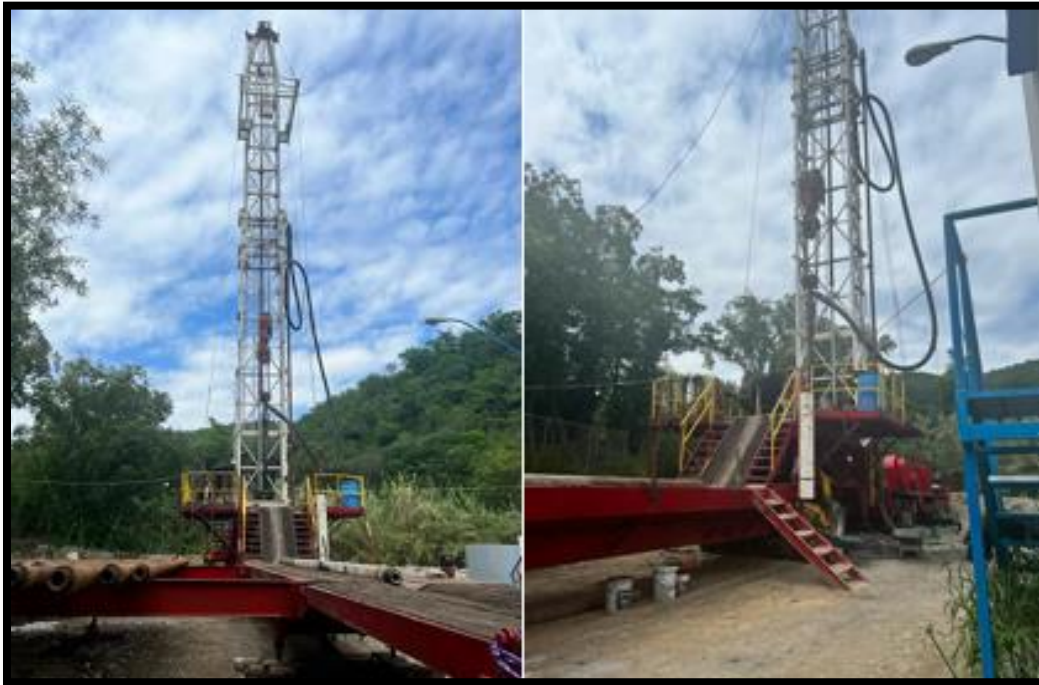
Figura 29. Exploración geotécnica in situ.
