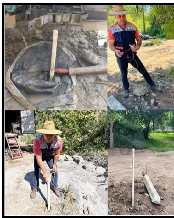
Figura 18. Instalación y rastreo de pozos.
