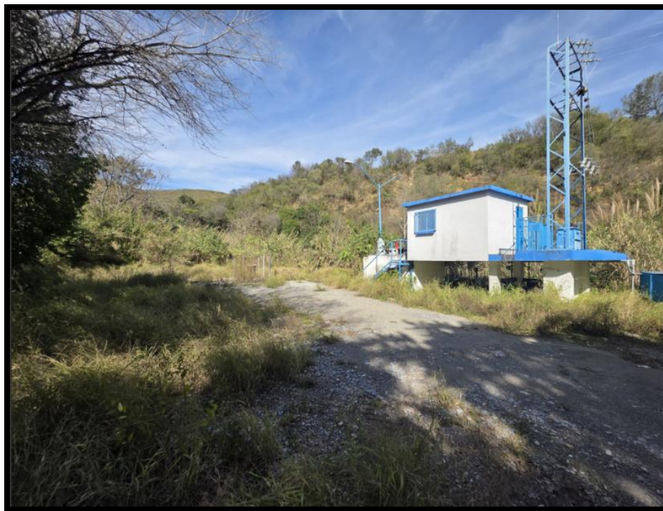
Figura 53. Panorámica del entorno donde se localiza el pozo y la infraestructura asociada.
