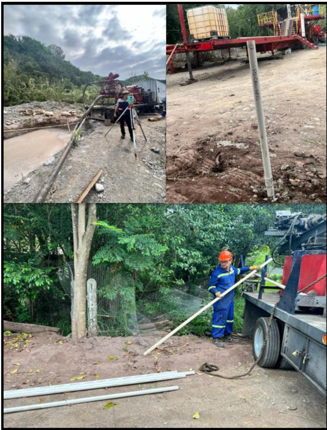
Figura 56. Trabajos operativos en campo.
