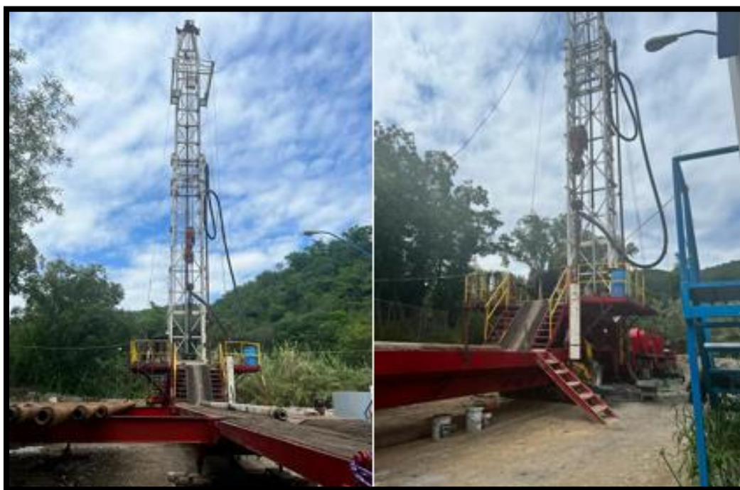
Figura 29. Exploración geotécnica in situ.
