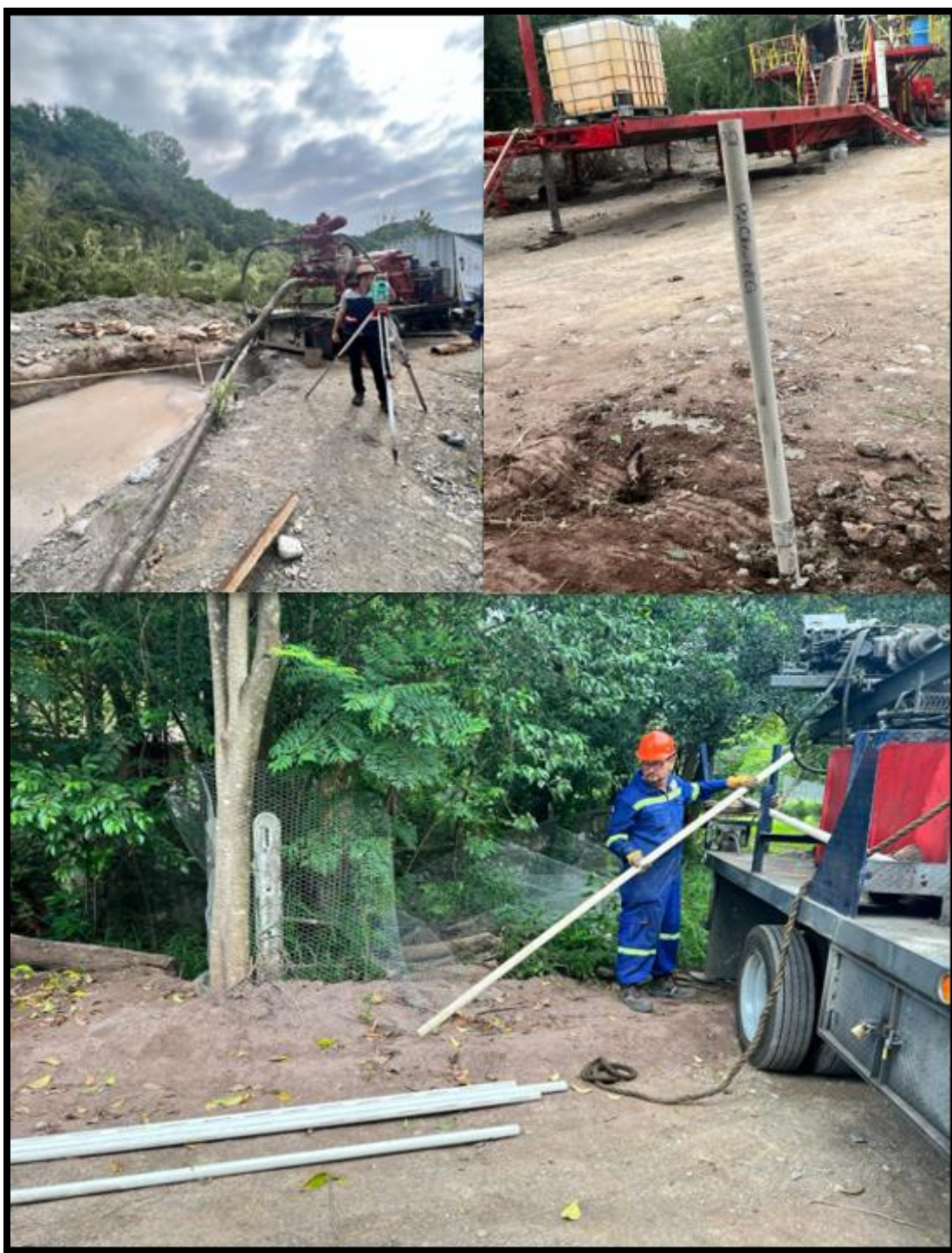
Figura 56. Trabajos operativos en campo.
