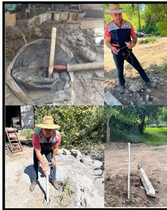
Figura 18. Instalación y rastreo de pozos. Nota: Elaboración propia.
