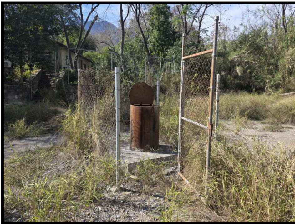
Figura 54. Pozo de extracción controlada desde el acuífero kárstico. Fuente: Elaboración propia.
