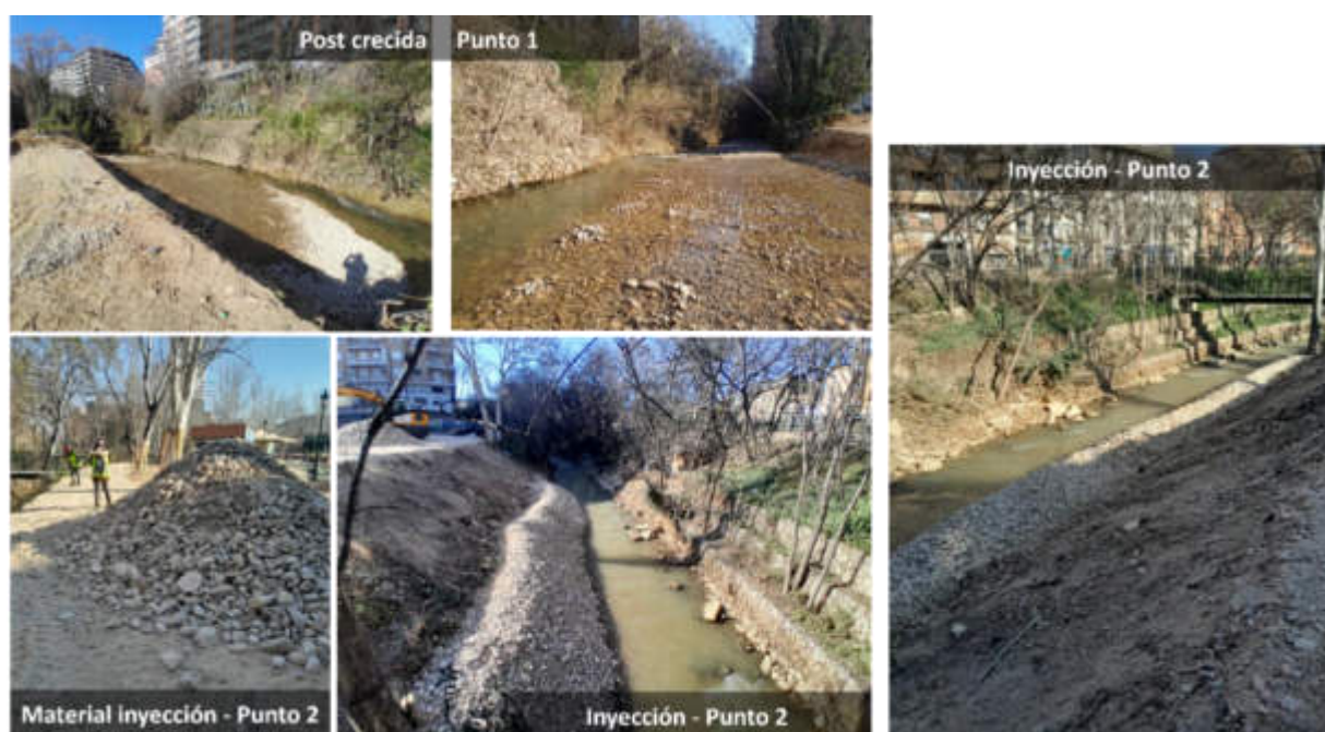
Figura 5. 8. Avances del proceso de inyección en los puntos establecidos. 16 de enero de 2025.
