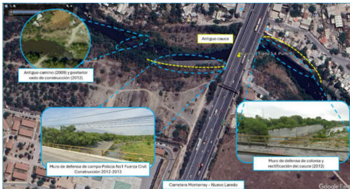
Figura 4. 13. Modificación del cauce natural por muros de defensa próximos al puente de la Carretera Monterrey – Nuevo Laredo.
