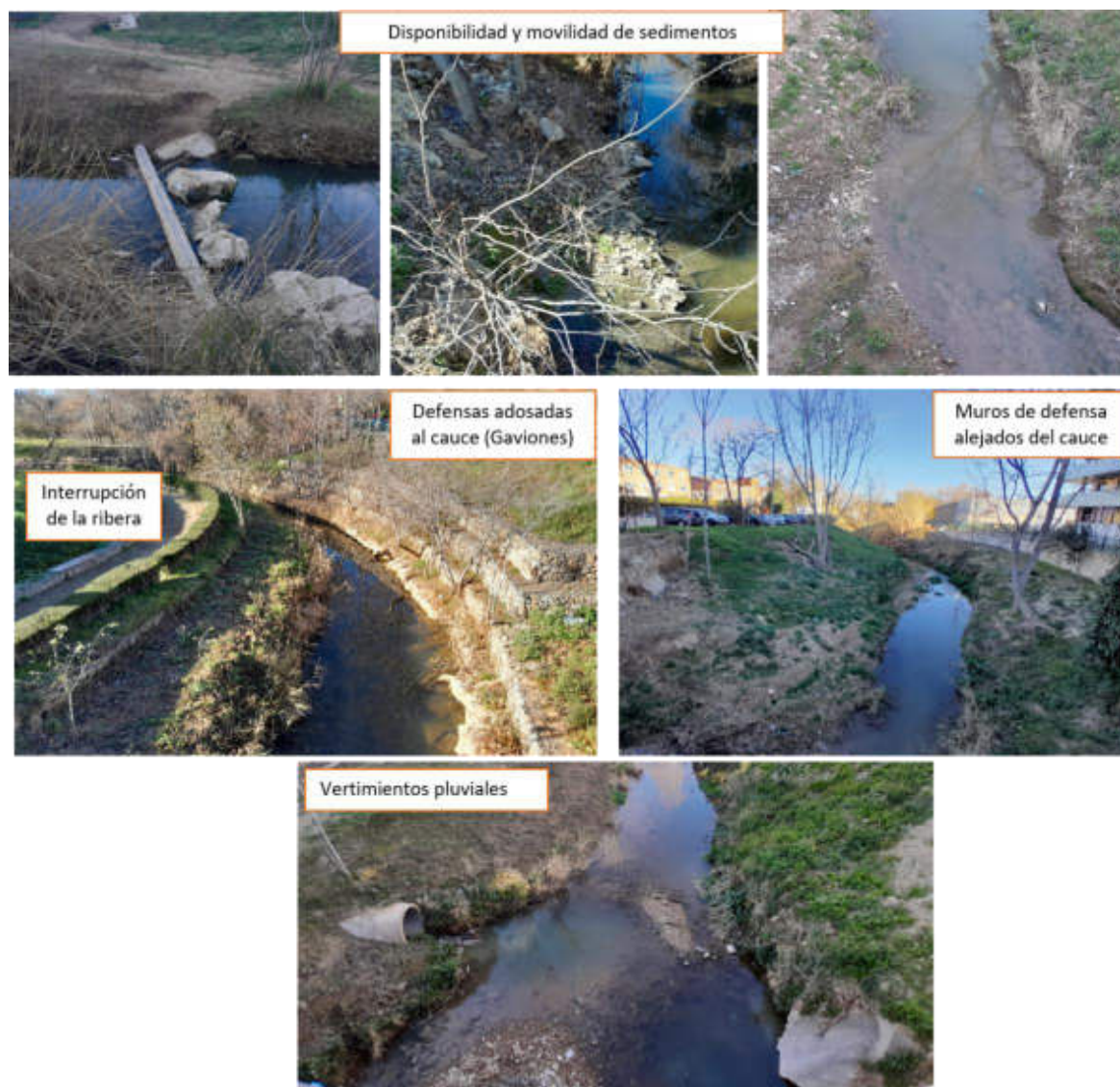
Figura 5. 4. Evidencia de alteraciones de la calidad hidrogeomorfológica en el Tramo 1 “ZPU de Zaragoza”, en el río Huerva.
