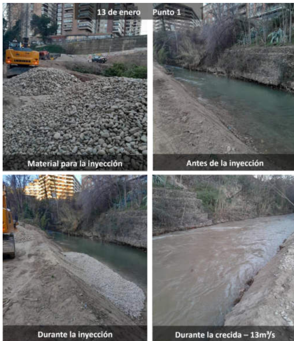
Figura 5. 7. Fases durante la inyección de sedimentos en el río Huerva.
