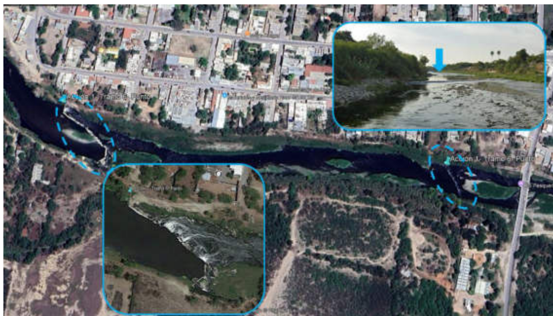
Figura 4. 14. Presencia de varias acequias en mal estado en el tramo 6.
