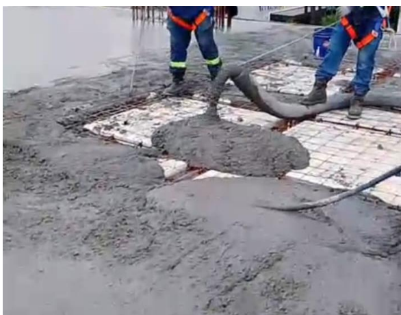
Figura 7: Concreto en estado fresco.
