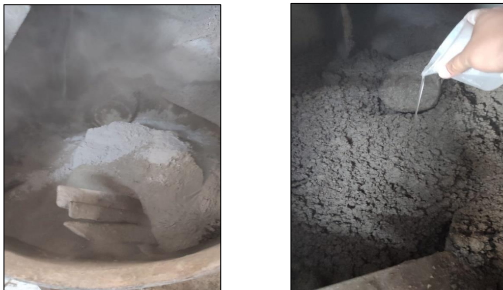
Figura 20: Adición de cemento, polvo de caliza y aditivos.
