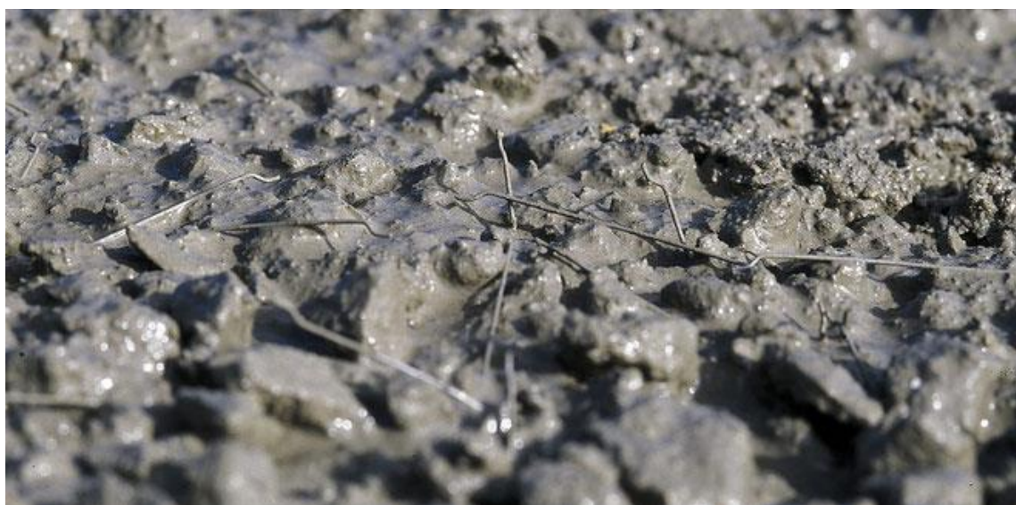
Figura 6: Concreto en estado fresco con fibras metálicas.
