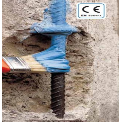
Figura 3. Varilla con aplicación de producto Mapefer 1K como recubrimiento anticorrosivo.
