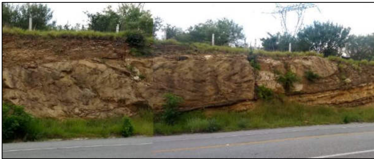
Figura 8. Secuencia de areniscas y lutitas arenosas de la Formación Mount Selman, en un corte sobre la autopista Monterrey-Reynosa, al NE de la presa El Cuchillo (elaboración propia, 2021).
