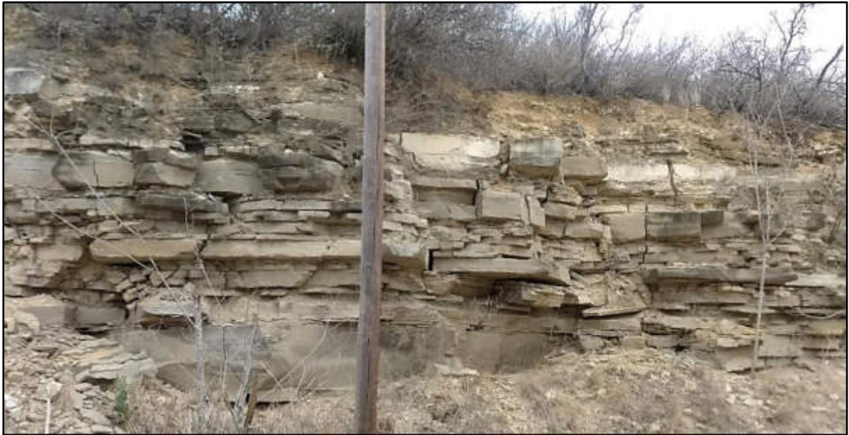
Figura 9. Fracturamiento por intemperismo en estrato de arenisca, afloramiento situado aguas abajo de la cortina de la presa El Cuchillo, China, N.L. (elaboración propia, 2021).
