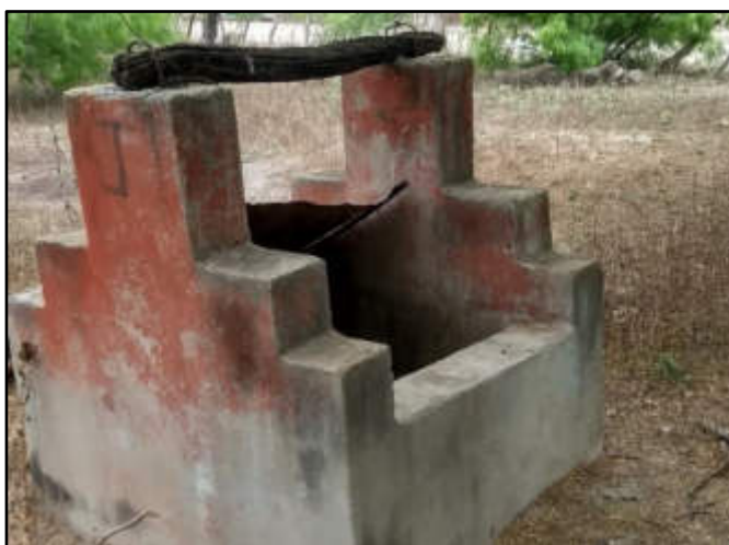
Figura 55. Identificación de la Noria 1 (NR-1) (elaboración propia, 2021).
