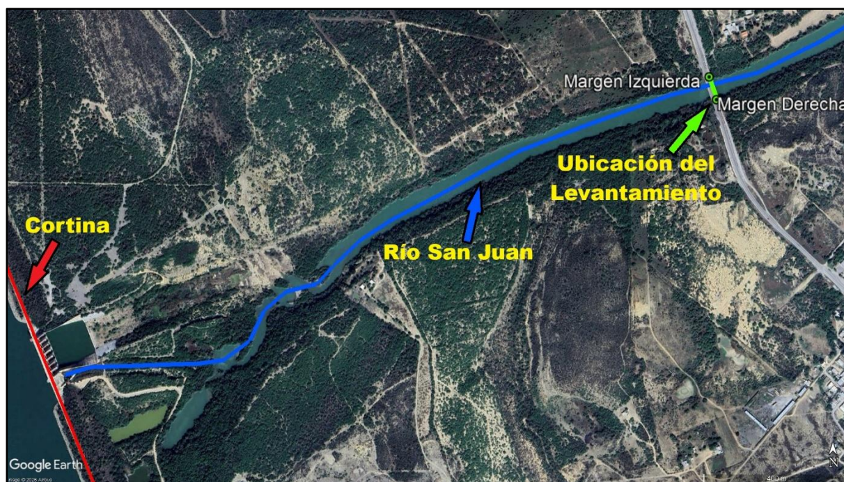
Figura 66. Ubicación del sitio de levantamiento sobre el río San Juan, aguas abajo de la cortina (elaboración propia a partir de imagen satelital de Google Earth Pro, 2026).
