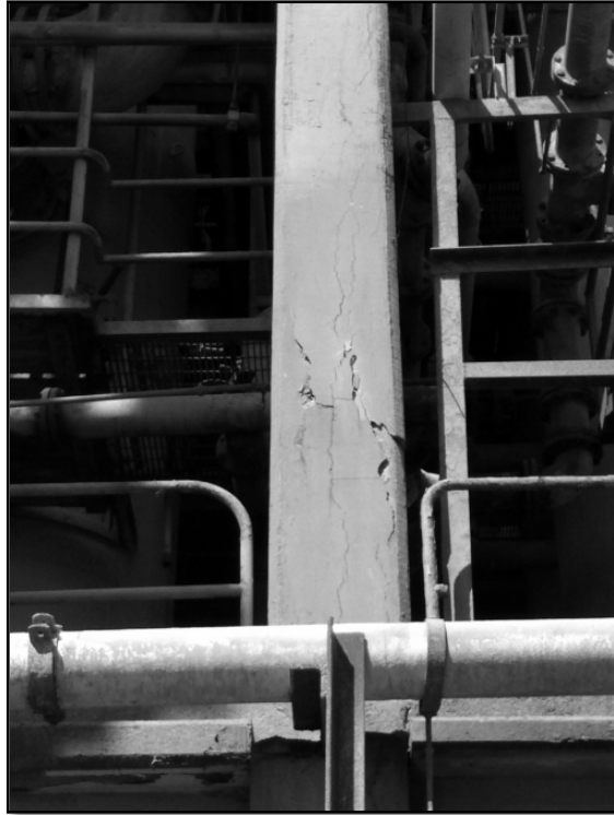
Figura 3. Grietas en columna de planta de carbonatos
