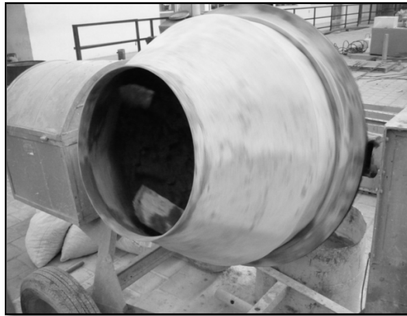
Figura 30. Mezclado del concreto
