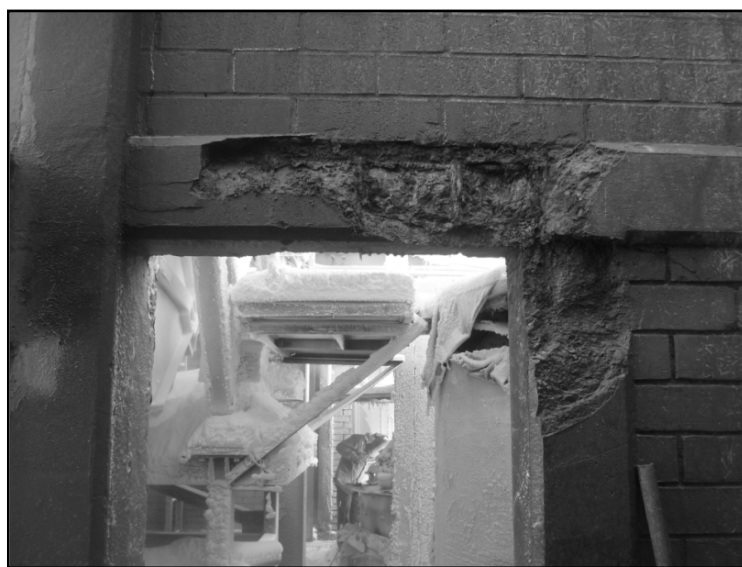
Figura 2. Daño en viga donde se aprecia el acero de refuerzo
