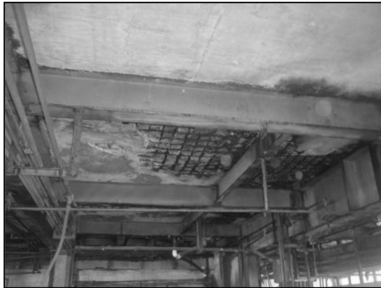
Figura 1. Daño en losa por corrosión
