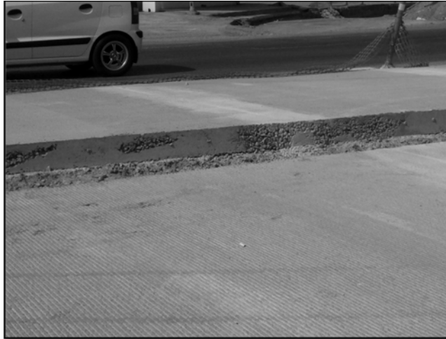
Figura 4. Pavimento con una mala colocación
