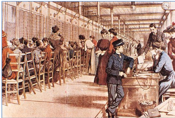
Figura 7. Aspecto de una Central Telefónica en sus inicios.
