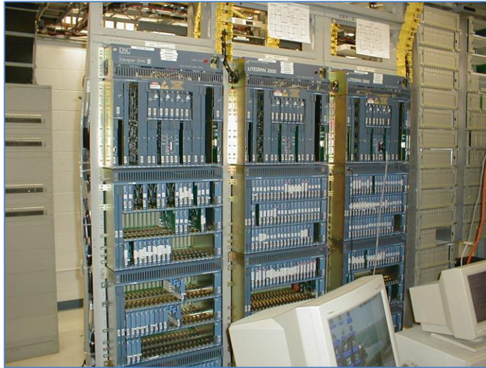
Figura 8. Aspecto de una Central Telefónica moderna.
