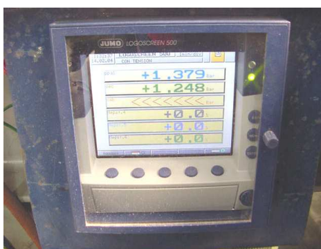
Figura 4.3 Equipo auxiliar usado para el monitoreo y registró la presión del aire que entra al sistema.
