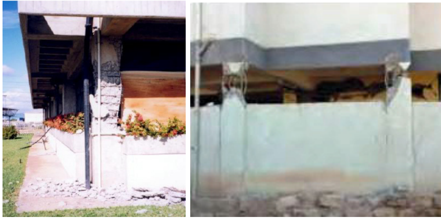
Figura 1.11: Falla por cortante debido al fenómeno de la columna corta [17].
