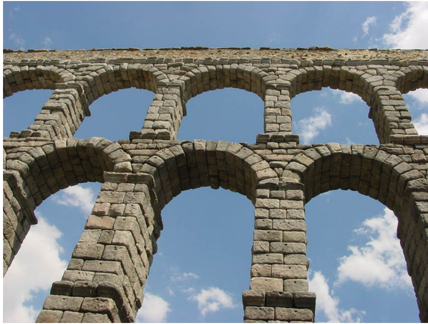
Figura 2.6: Puente del acueducto de Segovia.
