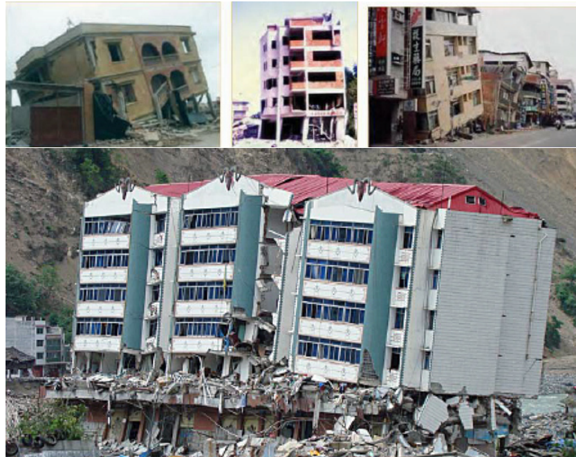
Figura 1.10: Estructuras con falla global debido al piso suave en planta baja [17, 82].
