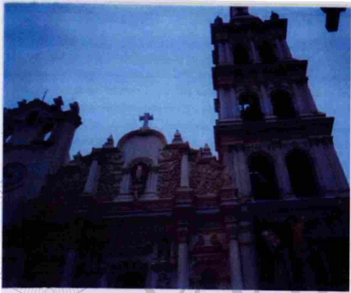
Vista Superior de la Fachada de la Catedral
