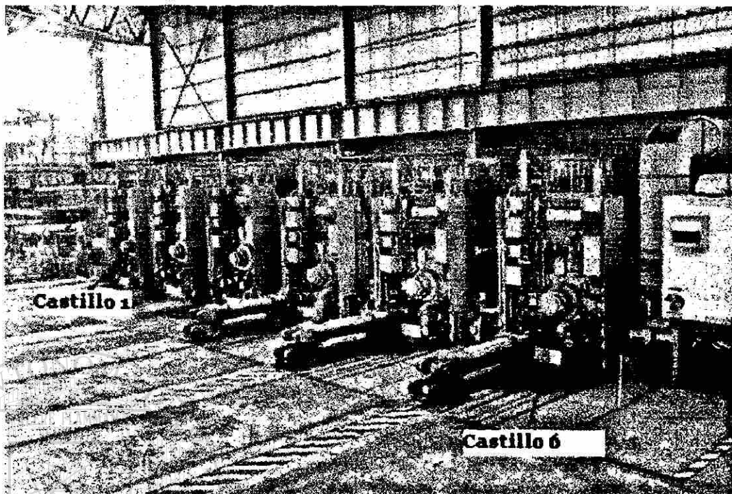
Figura 1.7. Zona del laminador en caliente de la planta compacta.
