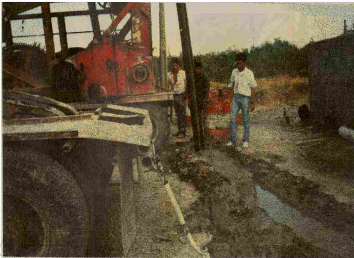
Figura 9.- Se muestra el canal de lodos que se forma al drenar éstos de la cuchara.
