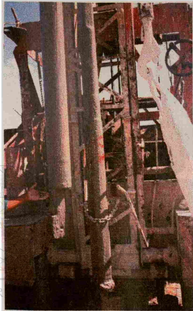
Figura 7.- Se muestra la cuchara recién salida del pozo con material fracturado de la perforación y agua añadida de forma artificial por el técnico.
