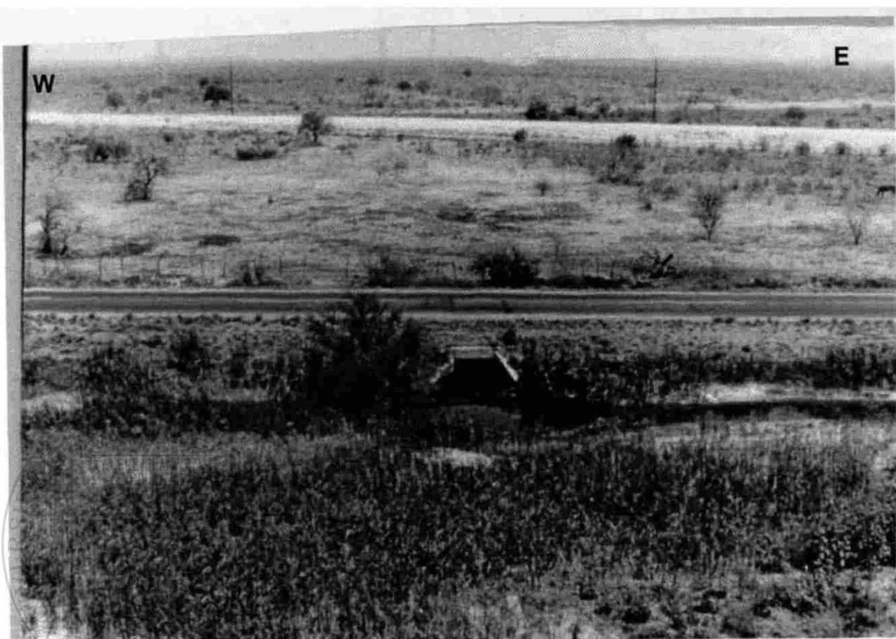
Figura 5.5 Filtración al pie del Dique vista hacia el norte (a 200 metros al W de la unión de la Cortina con el Dique).
