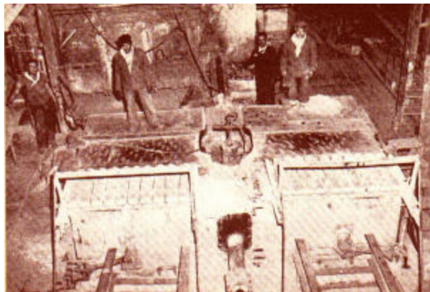
Paila desplantadora para separar el oro y la plata del plomo. Fundición 2, Monterrey, Nuevo León, México. (Tomada del libro Historia de un éxito. Centenario de Peñoles)
