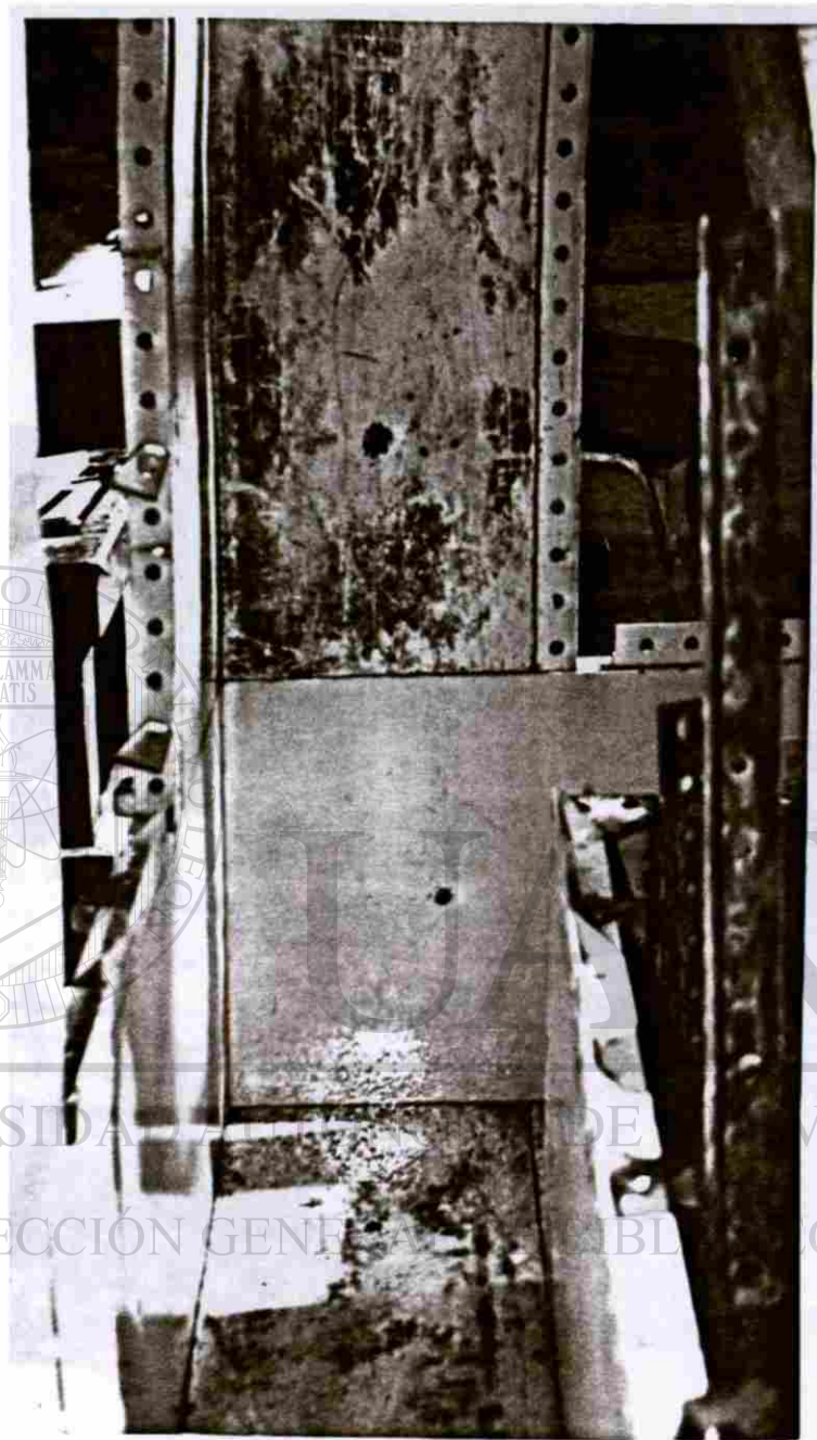
Foto 8.4. Detalle del cimbrado, es muy conveniente que las juntas sean a 90°.
