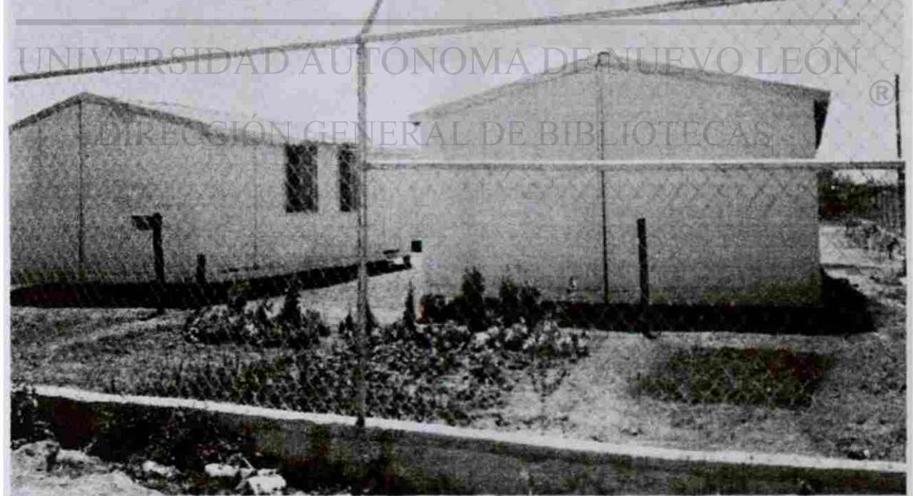
F4. Aulas móviles en antigua escuela secundaria
