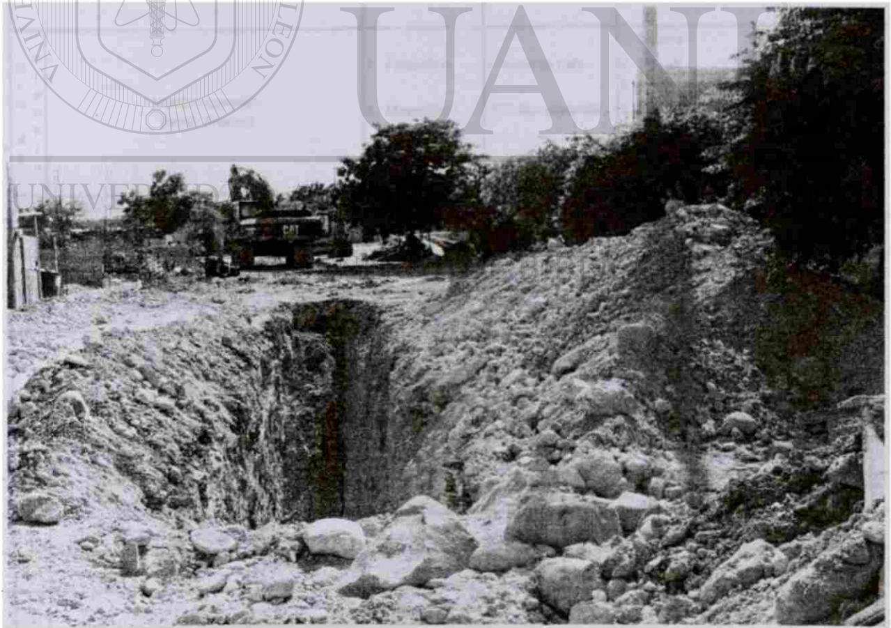
F12. Obras para la conexión del drenaje
