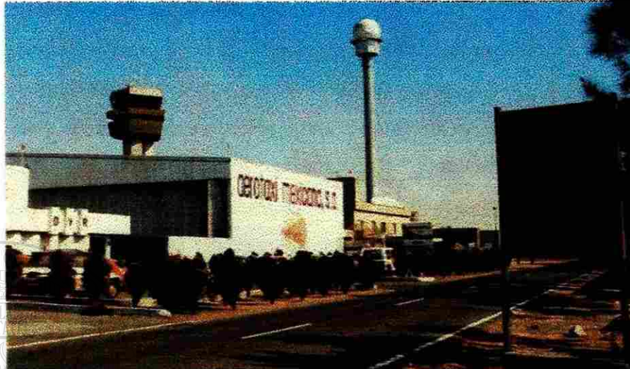
Figura 3.3 Torre para Radar de Superficie
