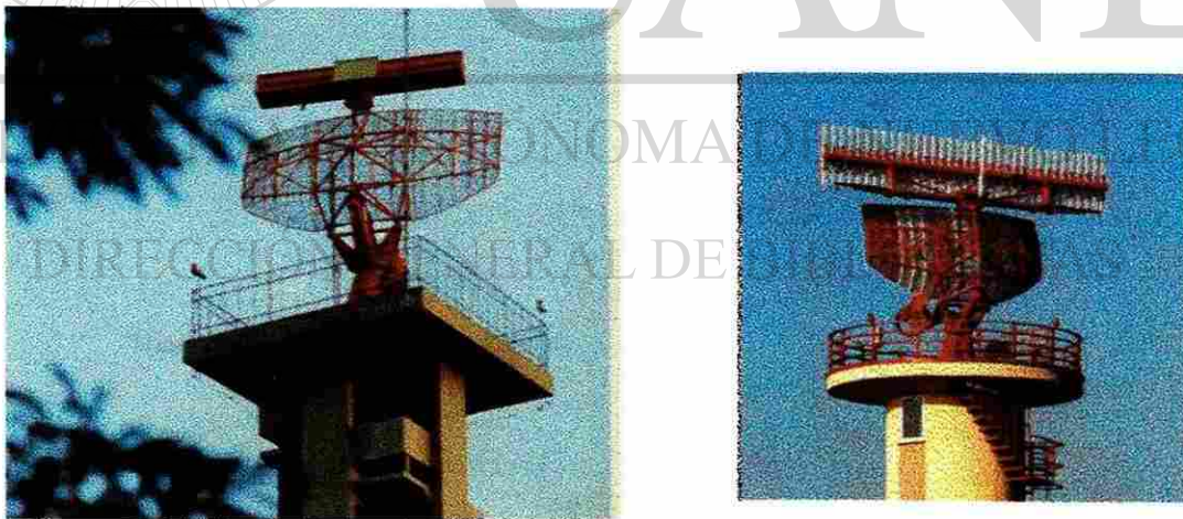
Fig.3.7 Antena de Radar de Aproximación
