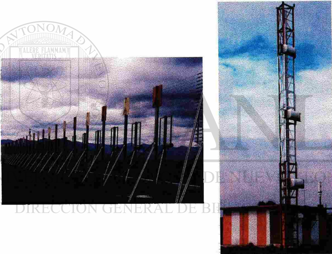
Fig. 10.9 Antenas Sistema ILS
