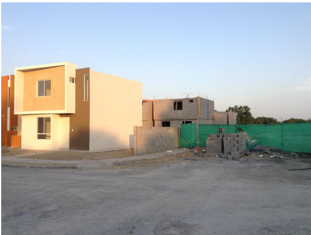
Imagen 18: Imagen de viviendas construidas y viviendas en proceso de construcción.
