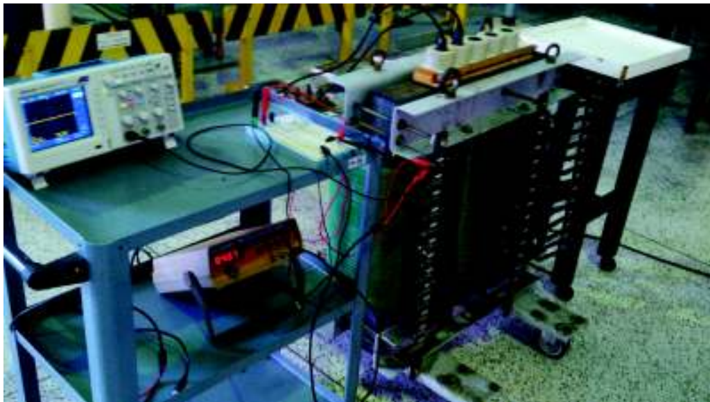
Figura 7.3: Transformador de distribución utilizado para la validación.
