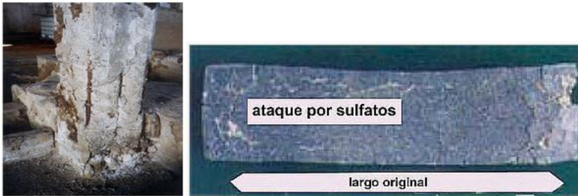
Figura 24. Patrón del ataque químico por sulfatos a estructuras de concreto y barras de mortero.
