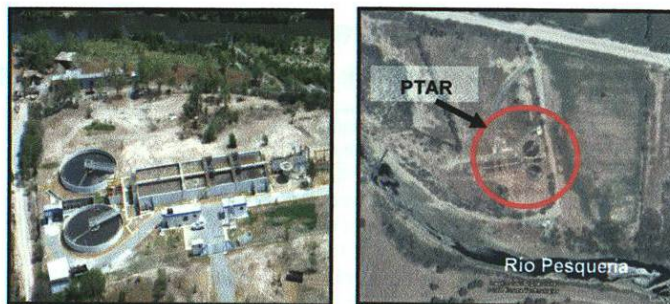
Figura 2.5. Foto (2005) y Foto Aérea de la PTAR. Fuente: PTAR y Google Earth.
